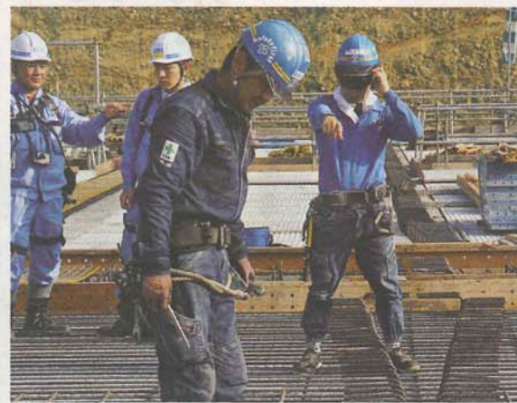
MRで鉄筋組立完了後の配筋チェック(右端の男性がレンズを装着して鉄筋位置をみる)
