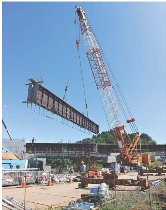
200t吊クレーンが旋回する
